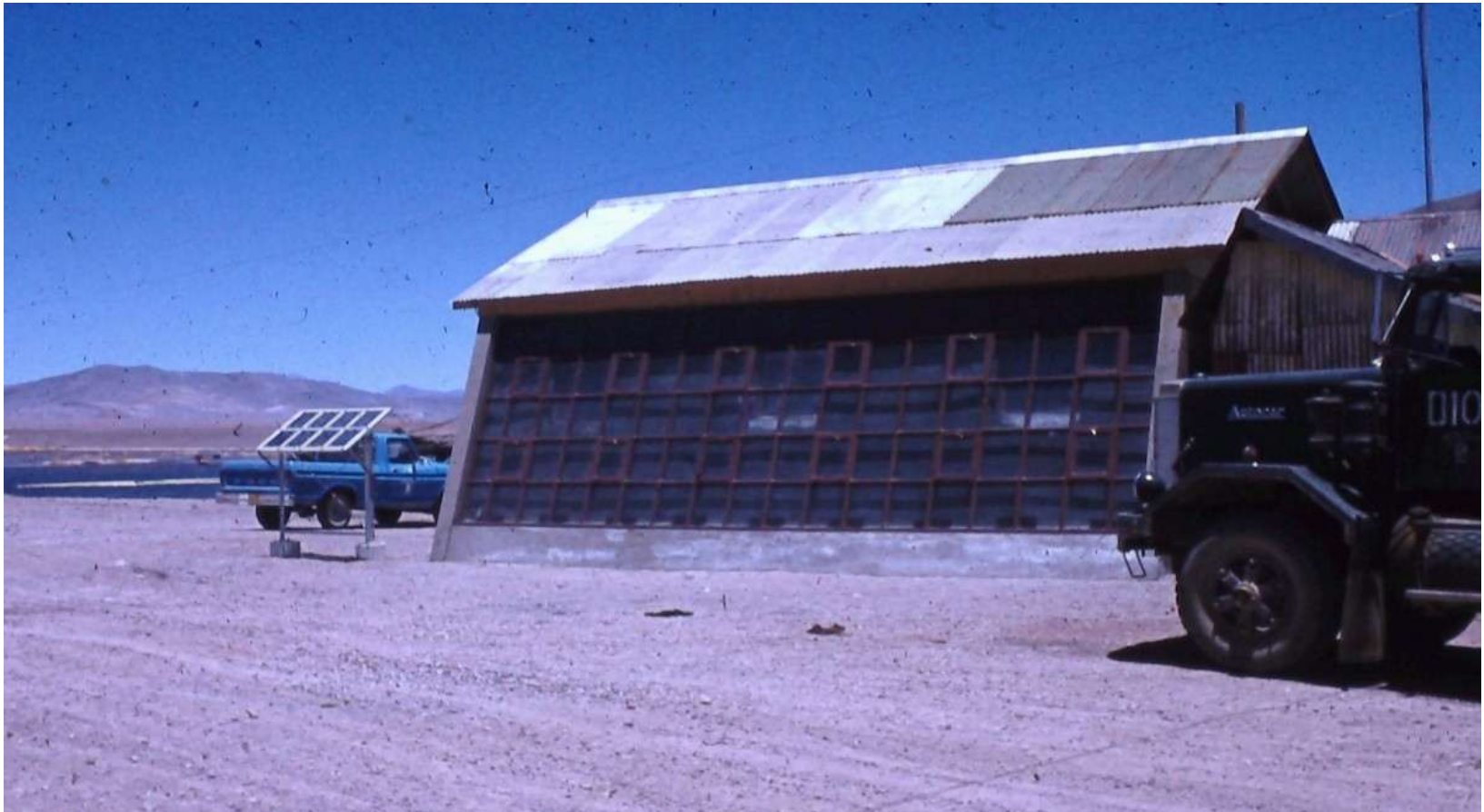
Casa Solar La Ola (sistema pasivo con muro Trombe) en operación desde 1982
