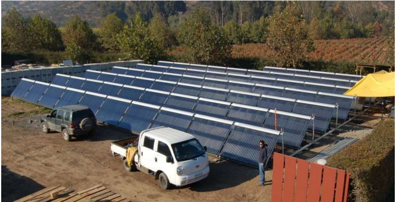
Instalación de sistema de tubos evacuados en Viña Gracia (sur de Rengo)
