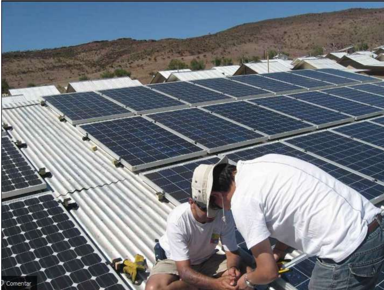
Instalación paneles sobre techumbre
