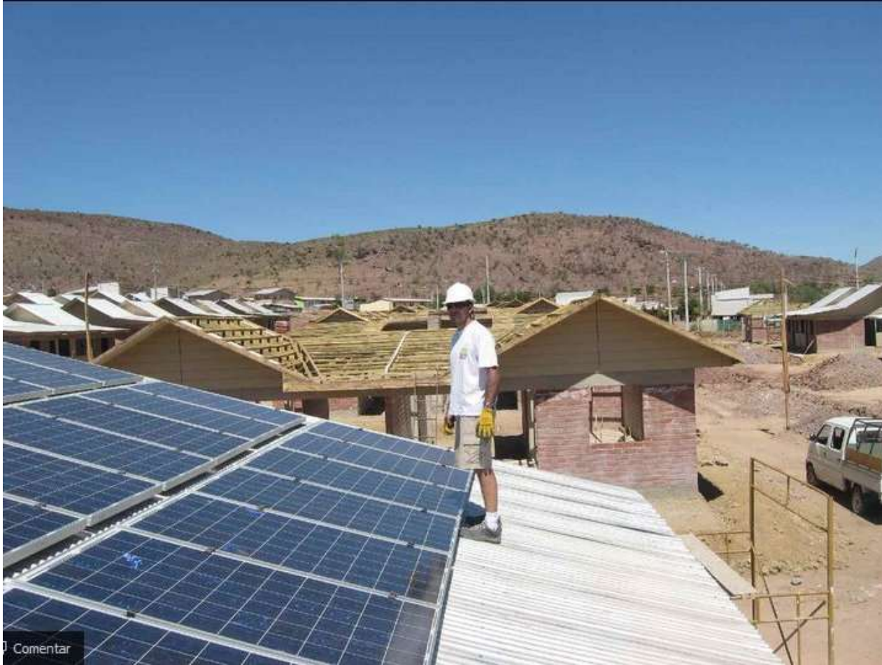
Paneles y casas en construcción
